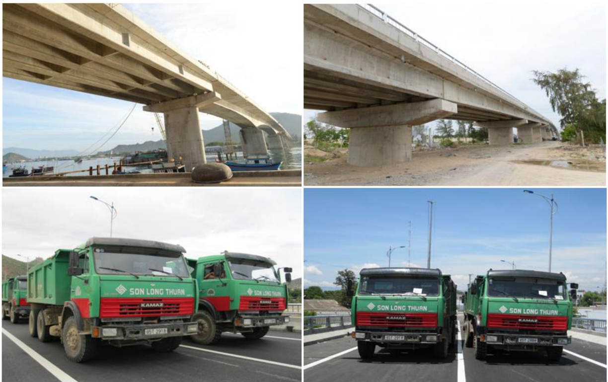
Hình 4. 14 Cầu Ninh Chữ [21] _ xếp xe 3 trục thực tế để thử tải đúng tâm trên cầu
