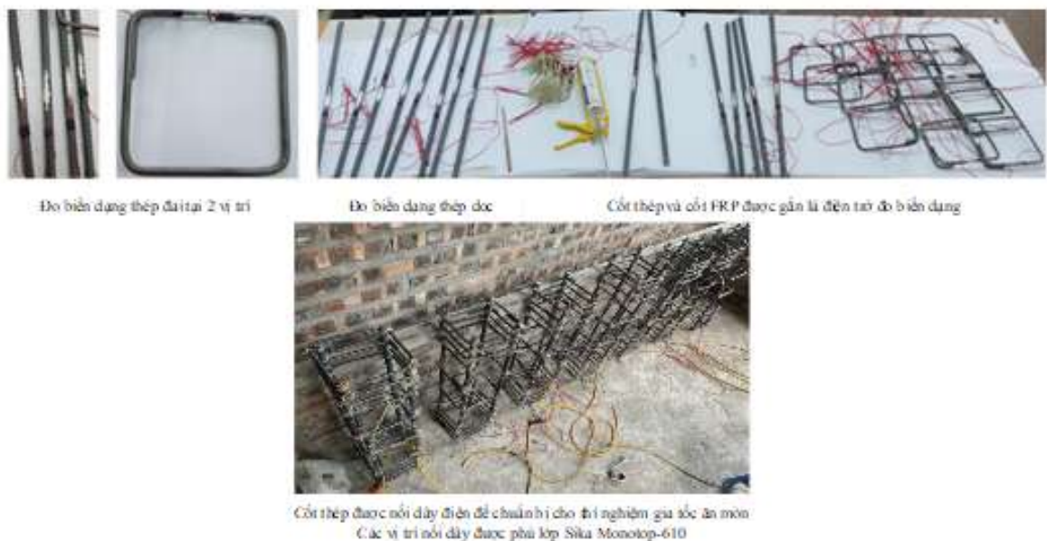
Hình 3.4: Chế tạo lồng cốt thép, gắn dây điện và lá điện trở đo biến dạng
