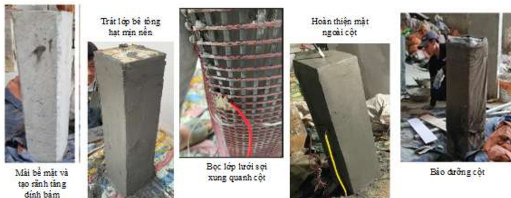
Hình 3.9: Các bước tăng cường cho cột bằng BTCLD
