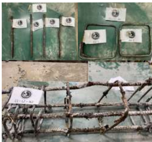
Hình 3.7: Cốt thép cột bị ăn mòn khoảng 8% sau thí nghiệm gia tốc ăn mòn
